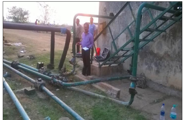
आकृति 2. अनुचित स्थान पर स्थापित टरबाइन टाइप प्रवाह मापक
