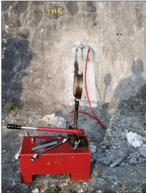
फोटो 1. भातसा बांध में फ्लैट जैक परीक्षण प्रगति पर
